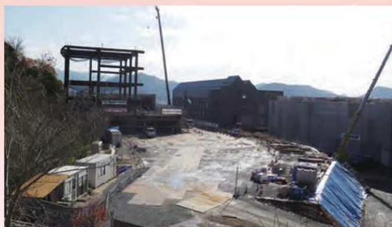
学部共通棟建設現場
