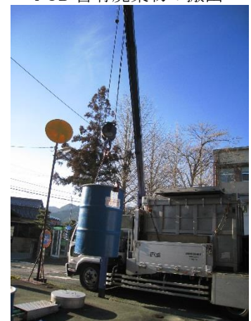
PCB 含有廃棄物の搬出
