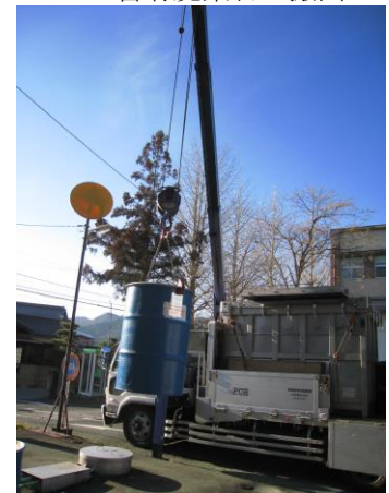
PCB 含有廃棄物の搬出
