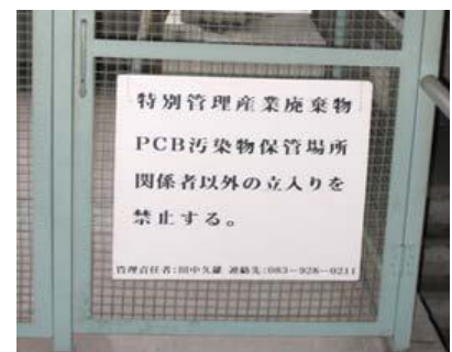
PCB含有廃棄物の適正保管
