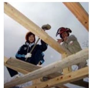
A 地域共生演習 阿武町「あったか村」棟上げ！
